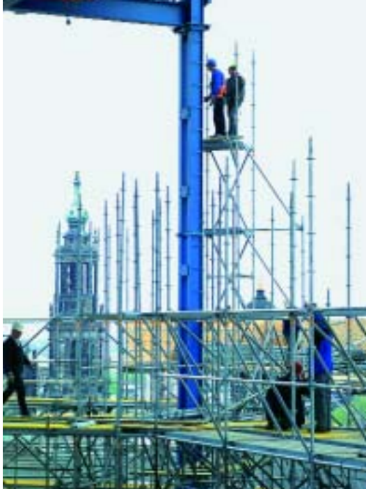
Die Arbeiten gehen planmäßig voran.
