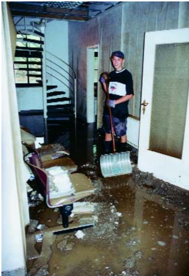
Die Praxis Havemann in Pirna: Nachdem das Wasser sank, konnten die Helfer das, was übrig geblieben war, nur noch ausräumen. Heute steht Dr. Kerstin Havemann freudig und stolz in ihren wieder aufgebauten Räumen.
