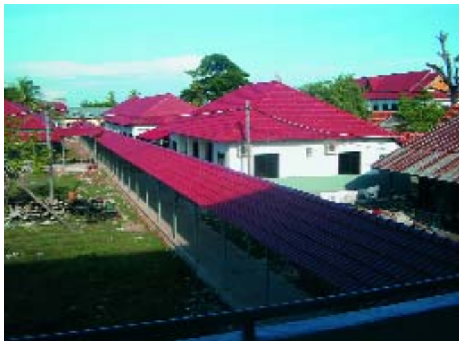
... und nach der Fertigstellung. Ein ganz neuer Luxus ist der überdachte Verbindungsgang.
