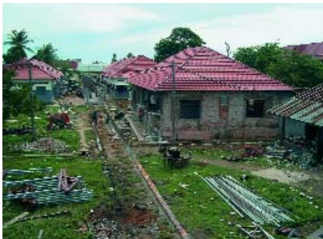
Das Gelände während des Umbaus ...
