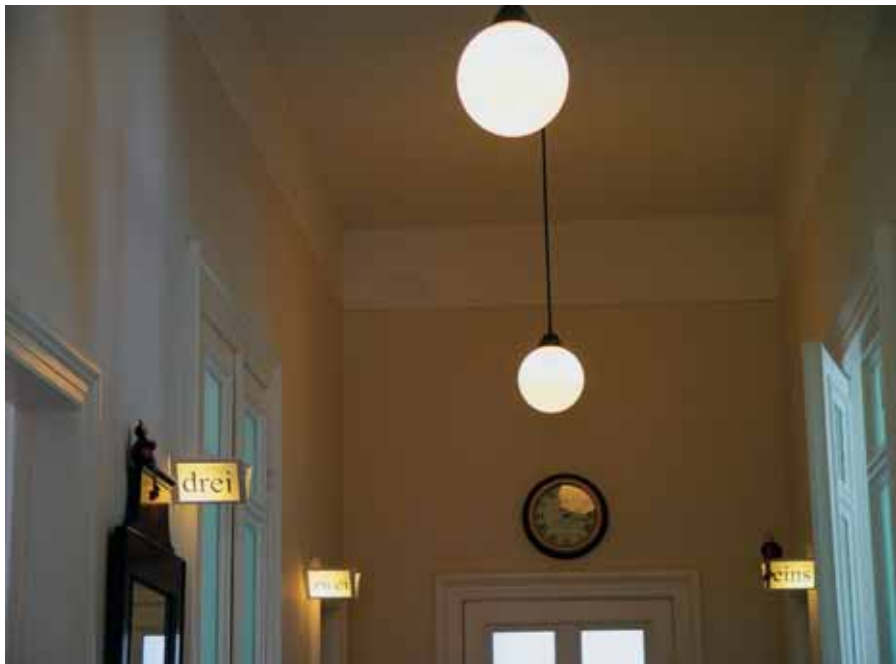
Die Kugelleuchten erhellen den langen Flur, opake Glasflächen in den Türen verstärken den Effekt, Leucht-Nummern erleichtern die Orientierung in das jeweilige Behandlungszimmer.
