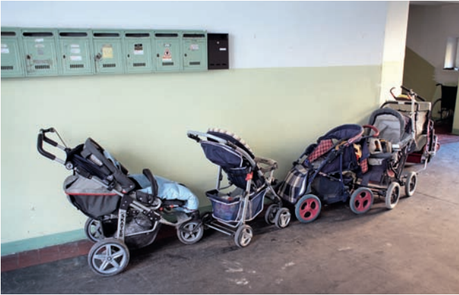
Zu beachten beim Immobilienkauf von Mietobjekten: Der Zustand der Hauseingänge und -flure.
