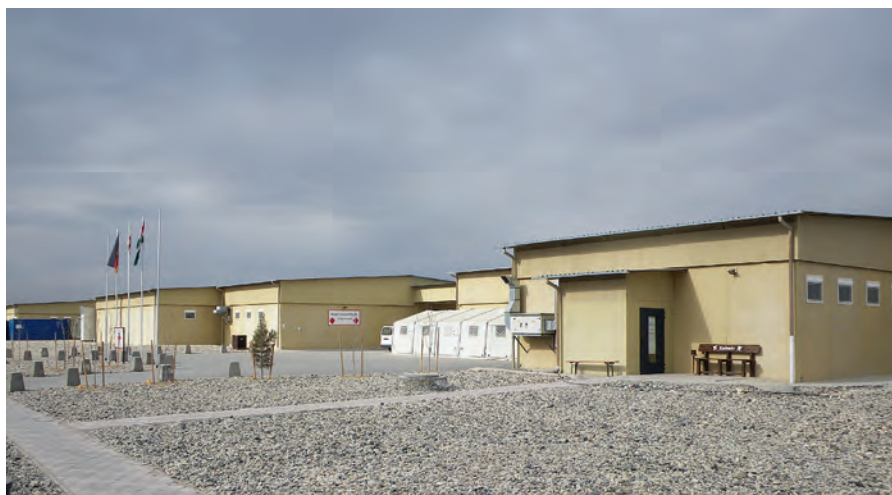
Im Feldlazarett sind insgesamt sieben Fachabteilungen sowie die intensivmedizinische Betreuung, die Bettenstation und das Labor untergebracht.
