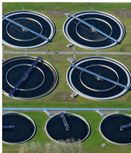
Kläranlage reicht nicht: Rückstände von chemischen Verbindungen können nicht vollständig abgebaut werden und gelangen in die Umwelt.
