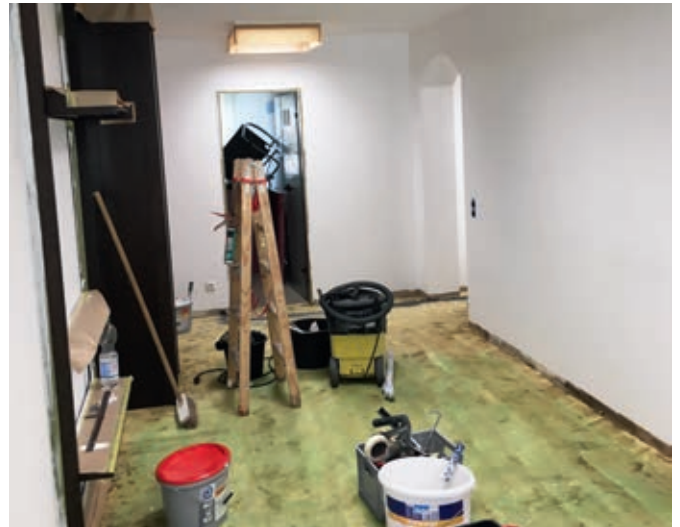
Der Wartebereich mit Garderobe ist in der Mache.
