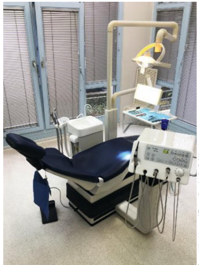
Das Ergebnis: Die Einheit nach der Sanierung – Tray und OP-Leuchte sind noch im Original.
