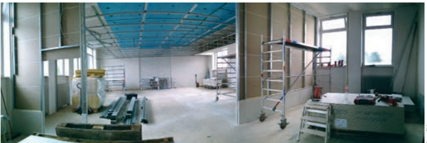
Die Trennwände, die nicht rund gehalten sind, werden installiert (links zum Backoffice, rechts die Wand zwischen dem künftigen Wartezimmer und dem Steri).
