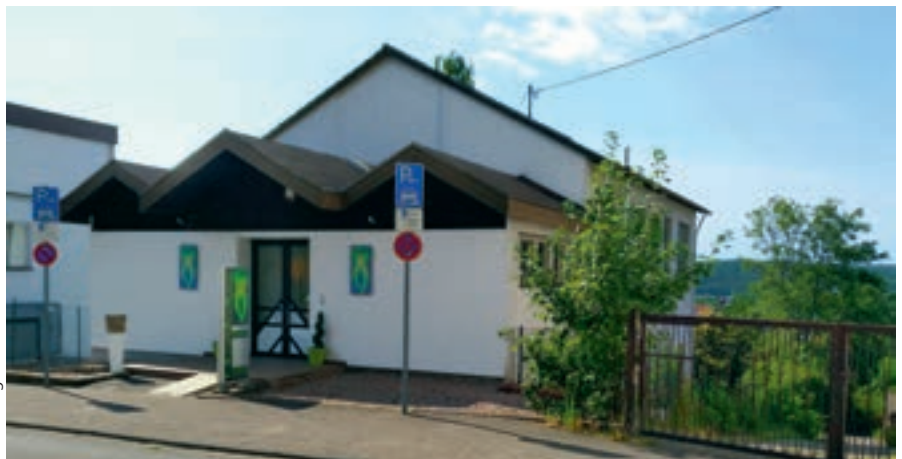
Außenansicht nach dem Umbau
