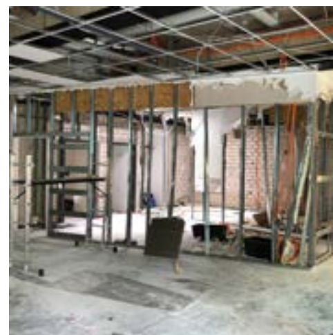
Das Erdgeschoss wurde zum Rohbau.
