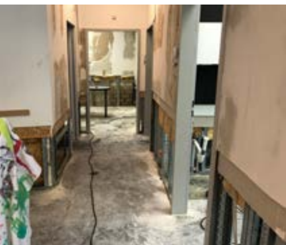
Zunächst wurde versucht, das Ständerwerk zu erhalten.
