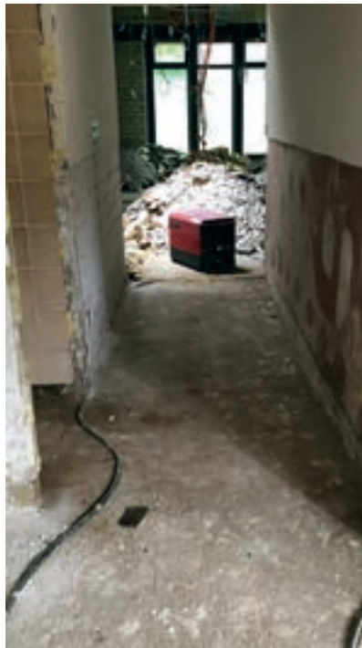
Zwischenstand: die komplette Entkernung.
