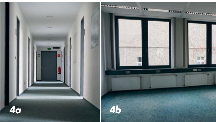
Bild 4: Insgesamt sollte die vorhandene Fläche mit Rücksicht auf die Wirtschaftlichkeit der Flächennutzung ein weitläufiges und offenes Gefühl erzeugen. All das bot die Ausgangssituation allerdings nicht: abgehängte Decken, Teppichboden, schmaler Flur mit vielen kleinen Büroräumen, der Charme der 90er. Ein gesamter Abriss war nötig.
