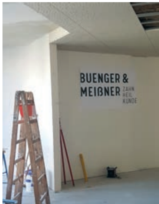
Die geschlossenen Wände verkleiden all die Arbeit, die dahinter steckt.
