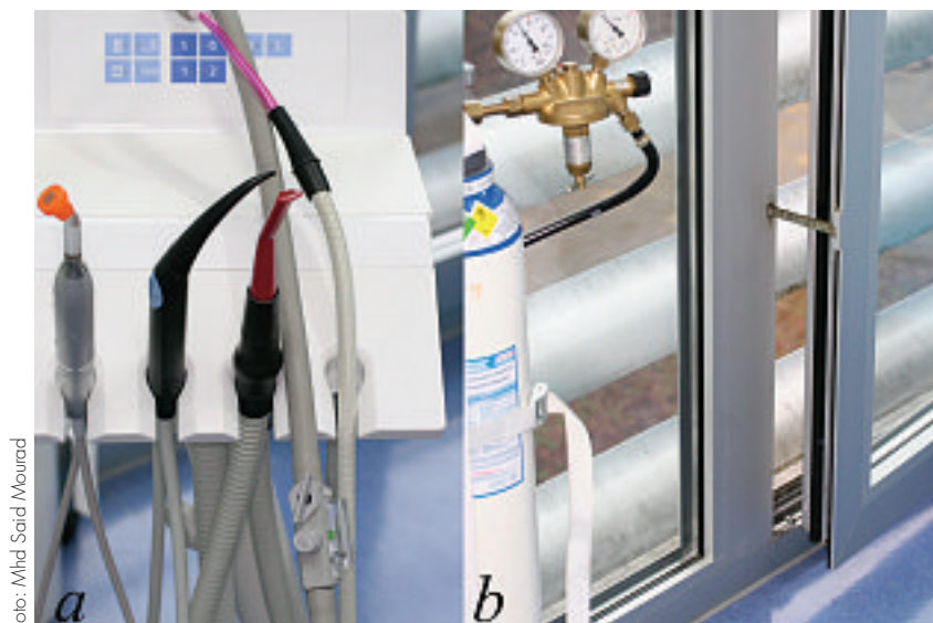
Abb. 3: Externe Absaugung (a) für ausgeatmete Luft zur Verringerung der Arbeitsplatzbelastung durch Lachgas ist beispielsweise über das Saugsystem der Behandlungseinheit möglich. Raumabsaugung beziehungsweise -entlüftung im Bodenbereich (b) durch ein großes Bodenfenster zur Verringerung der Arbeitsplatzbelastung, denn Lachgas ist schwerer als Luft und sinkt daher zu Boden.
