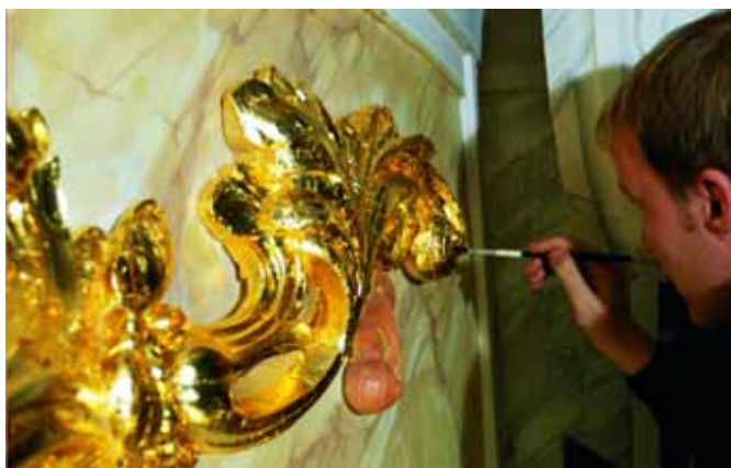
Vergoldungsarbeiten an der Orgelempore (li) und Blick auf den Altarraum (re.)
