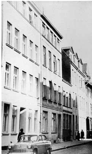
Zwei benachbarte Wohn- häuser, in denen von 1919 bis 1938 das Rostocker „Zahnärzt- liche Lehr- institut“ un- tergebracht war (Auf- nahme aus den 1950er- Jahren)
