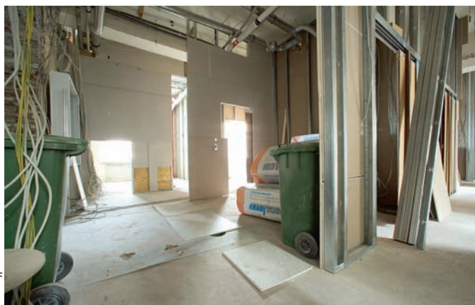
Der gesamte Umbau erstreckte sich über einen Zeitraum von zwei Monaten.
