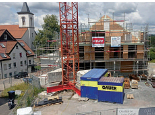
Noch ist hier Baustelle, aber demnächst eröffnet das „Vivendi-Quartier“ seine Pforten.
