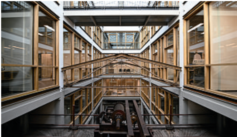
Das ehemalige E-Werk in Brandenburg an der Havel ist zur Universitätsklinik für Zahnmedizin der MHB umgebaut worden. Oben sieht man die in U-Form angeordneten Behandlungsräume.
